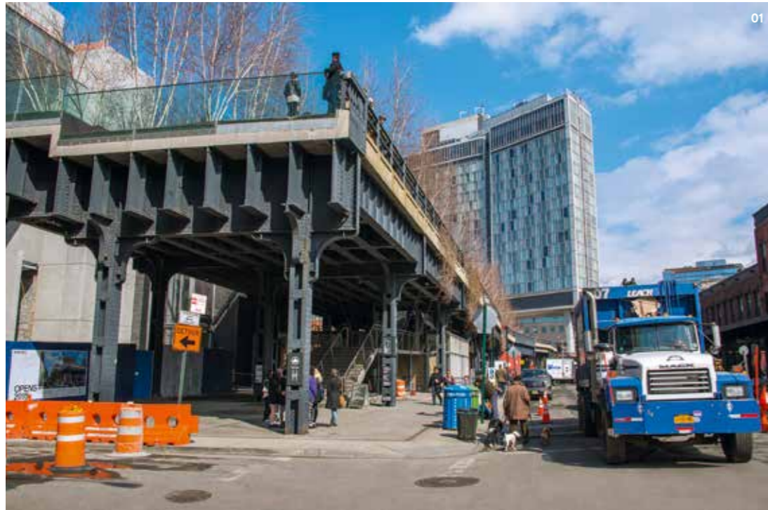
01 Industrielles Erbe Der High-Line-Park ruht auf den gusseisernen Stützen der Bahn
